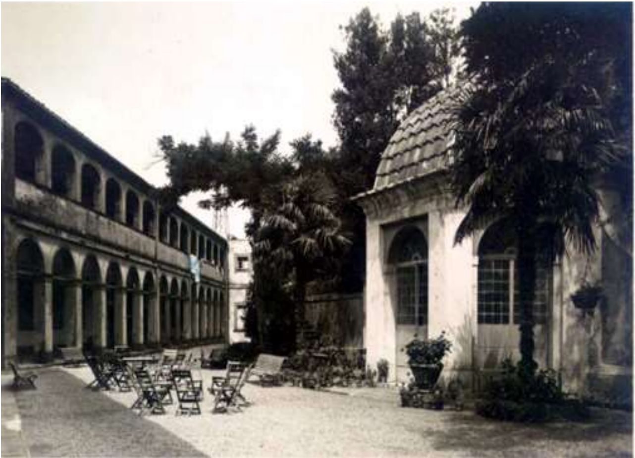
Prospetto Nord e Cappella delle Regie. Terme di San Giuliano
