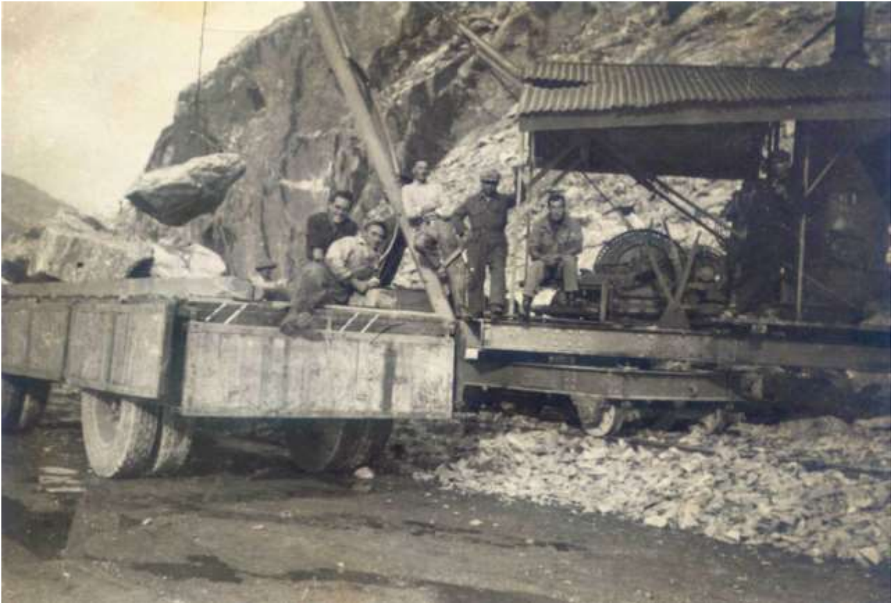
Cava Cristiani – Carico materiali
