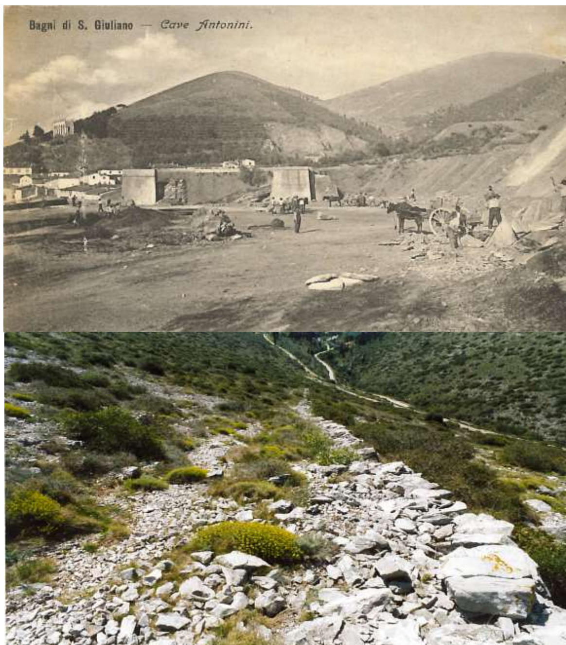
Via di lizza per il trasporto a valle dei blocchi di marmo del Monte Pisano
