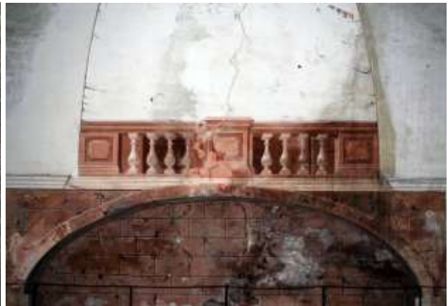
Interno del Cisternone
