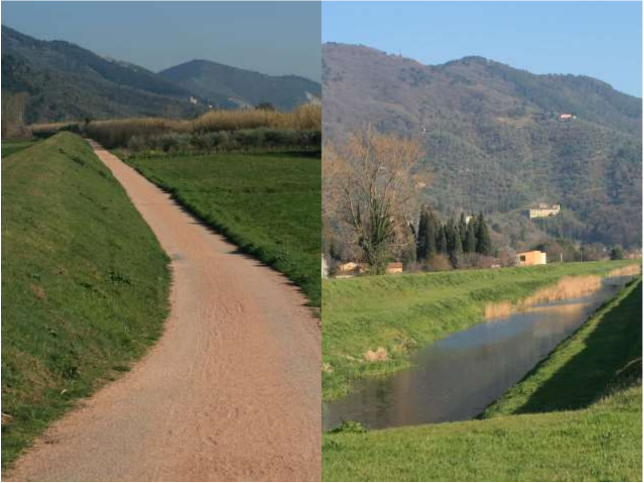
Pista ciclabile “Itinerario di Puccini”, nel tratto adiacente al Canale Ozzeri - Colognole
